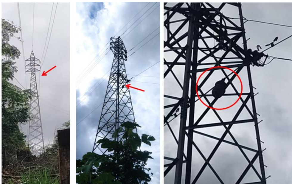
Línea caída por fractura del aislador.
