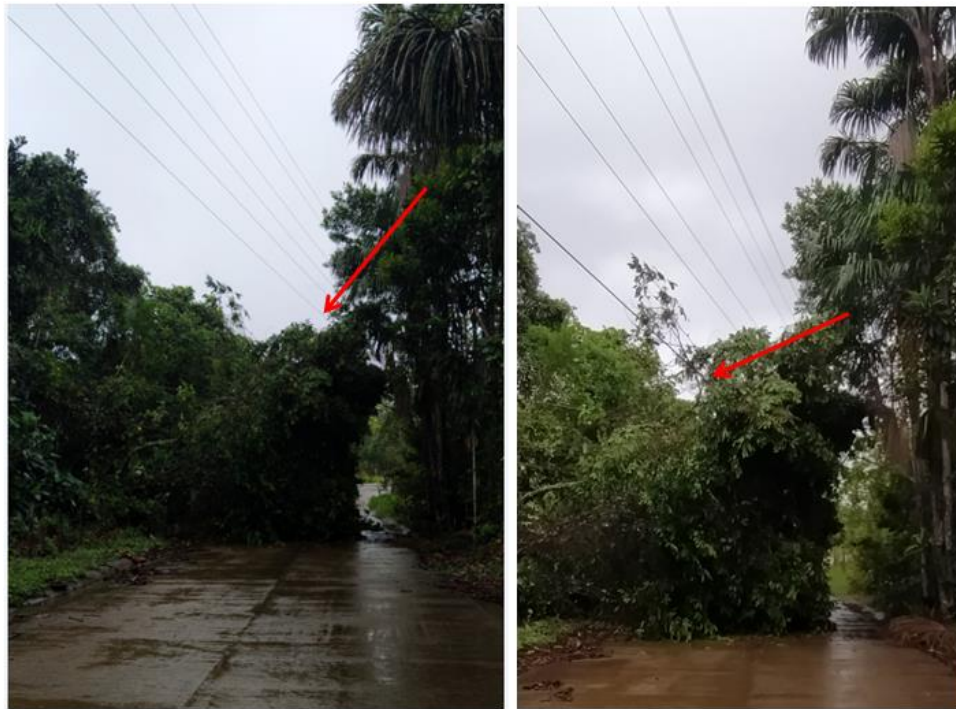
Línea afectada por caída del árbol.
