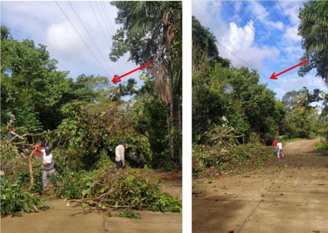
Limpieza y retiro del material vegetal.
