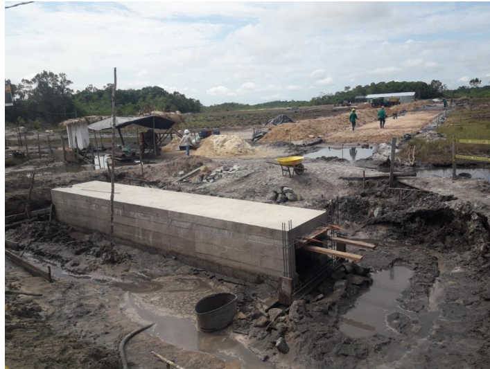
Construcción box coulvert y vía de acceso al lote
