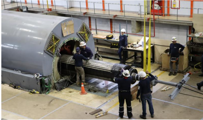
Proceso de extracción del rotor del Generador de la unidad 3
